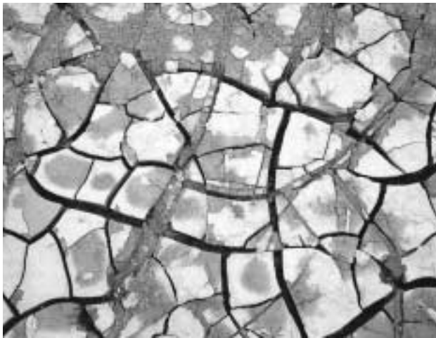
「7. 13水害でできたひび割れのようす」
