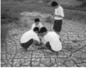
図9 土砂がたい積してでき たひび割れ
